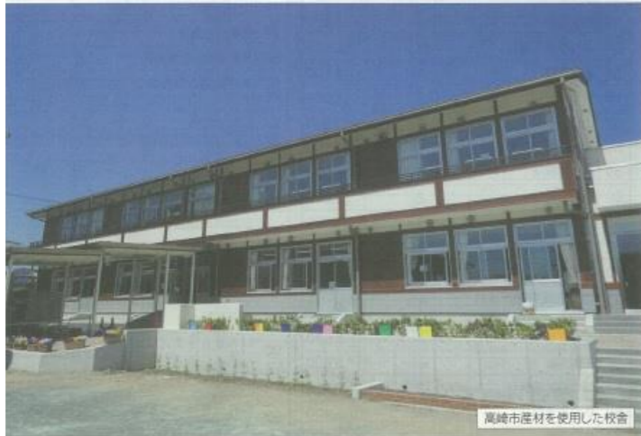
高崎市産材を使用した校舎
